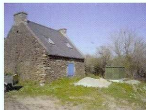
Des transformateurs implantés n'importe où sans tenir compte de l'environnement immédiat. Ici à Kerohet,
